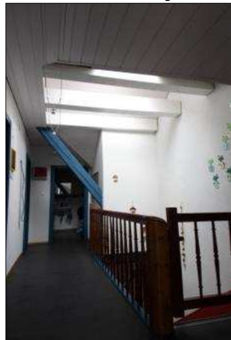
Hall d'entrée - Combles
