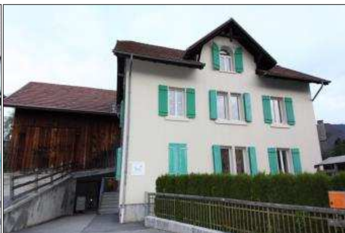
Façade côté sud
