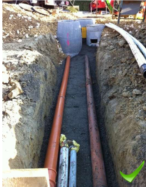
Canalisations AVEC assise bétonnée
