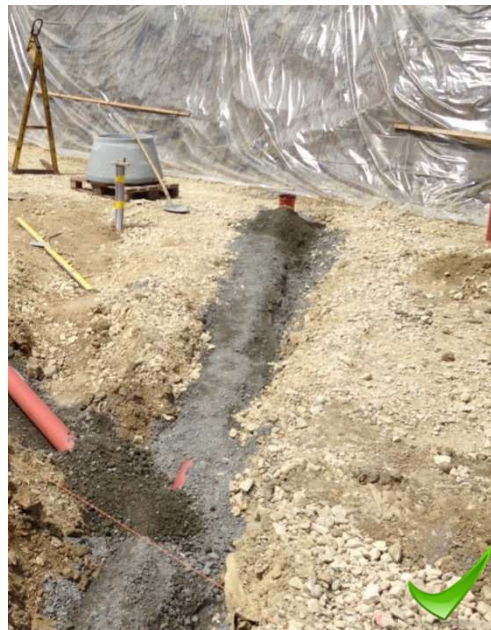
Canalisations en cours de bétonnage
